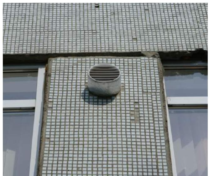
Для различных видов отделки фасада регулируется длина выступа корпуса Системы из стены. Например, под «навесной вентилируемый фасад» или под так называемый «мокрый фасад».
