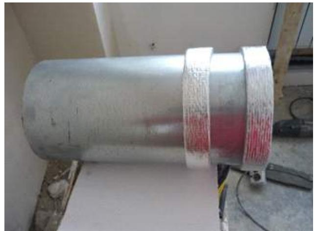
4) Внутреннею часть телескопического корпуса с вмонтированными в него вентиляторами, рекуператором, фильтрами вставляем во внешнею часть корпуса.
